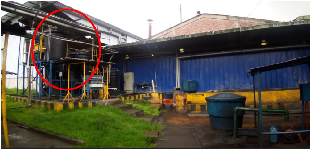
Fotografía No. 05. Transporte por canales de aguas lluvias
